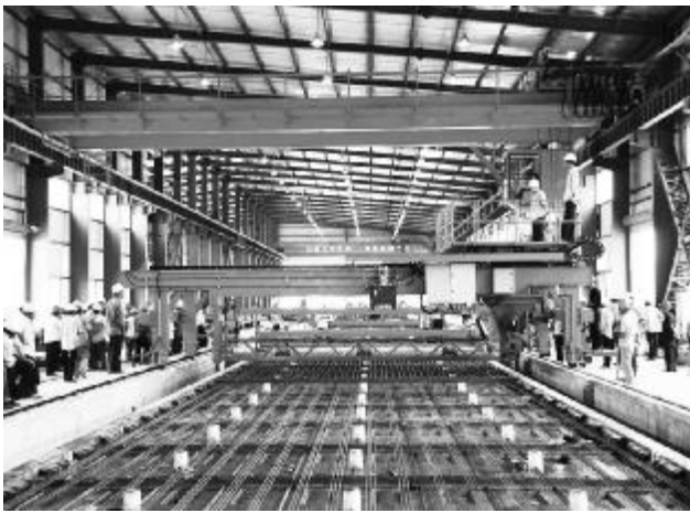
沪杭项目松江轨道板场
