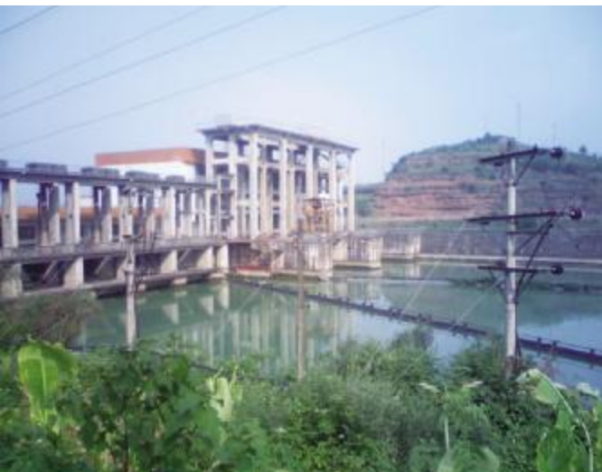
2009年夏,扩建后的马回水电站大坝
