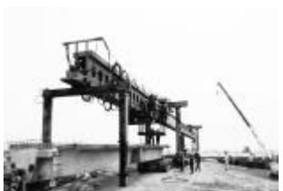
▲6月29日,由土木公司承建的唐山滨海大道南排涝沟中桥成功架设第一片箱梁。 刘灿/摄
