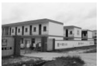
▲日前,在通往阳江核电厂的道路两边,几栋矮小的房子围墙上悄然之间印上了“中国建筑”的蓝色大字,推开院门,就是经过简单装修的中建二局阳江核电厂项目总经理部的临时生活和办公区。项目部按照总公司CI标准在仅仅一周的时间内就高品质地完成了外墙、围墙的装修和部分内墙的修整。金五一 张文俊/摄
