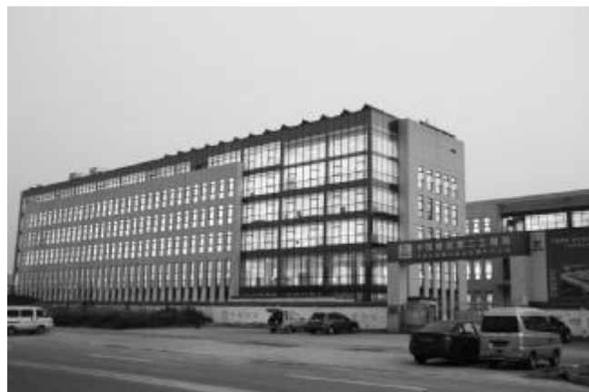
▲6月29日,由三公司施工的北京邮件综合处理中心工程提前计划工期20天通过了四方验收。中国邮政集团高层领导对工程给予了高度的评价。目前,邮件综合处理中心工程装修已经全部完成。三期工程目前正在紧张施工中。 陈一鸣/摄
