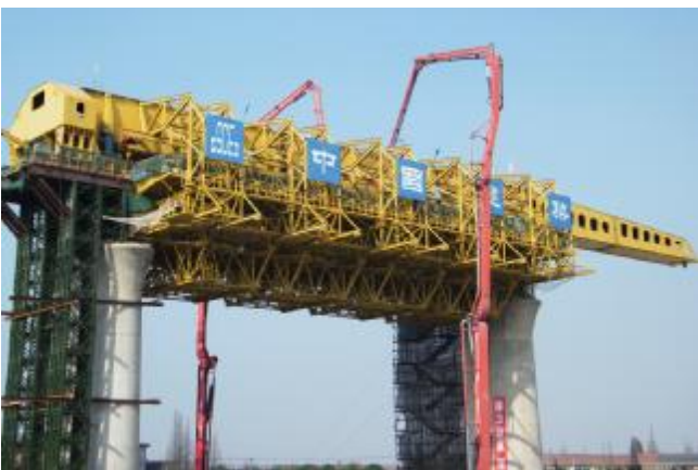
沪杭项目移动模架施工现场
