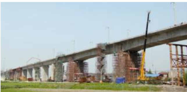
沪杭项目连续现浇箱梁施工现场
