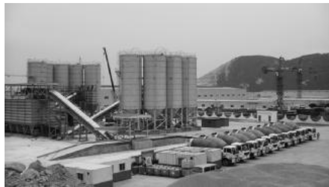
▲台山核电站新增5#、6#搅拌机设备安装已经基本完成,正在调试过程中。5#、6#搅拌机主要为一期常规岛土
