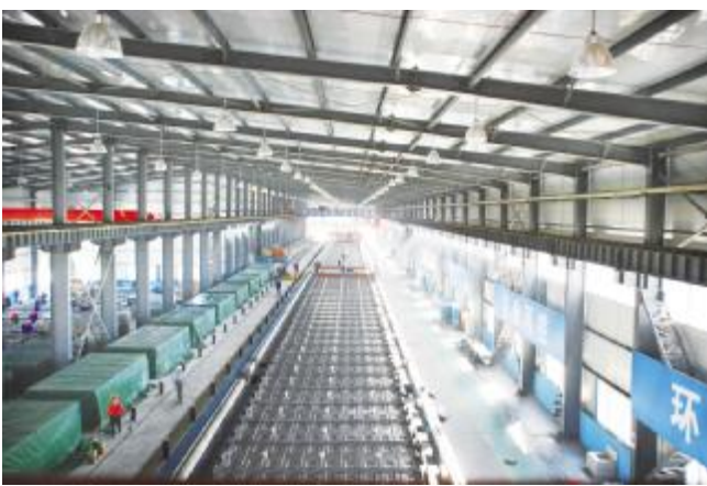
沪杭项目松江轨道板场车间内情景
