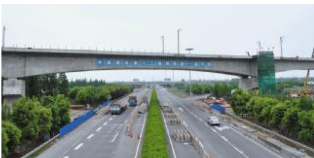
沪杭项目跨A30高速公路连续现浇箱梁
